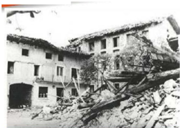
1976 Terremoto del Friuli
